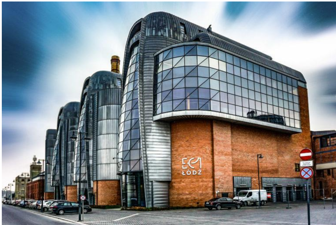
Elektrociepłownia EC-1, obecnie Centrum Kultury i Nauki EC-1. 24
